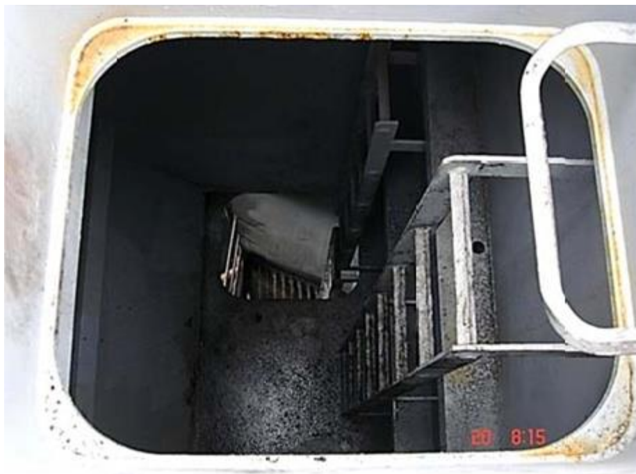
Мал. 1. Жорсткий вертикальний трап.
